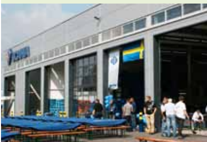
Am 28. Mai wurde der Neubau von Scania in Oberschleißheim feierlich eingeweiht.
